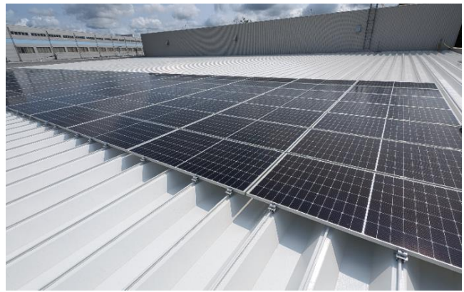
太陽光パネル設置の様子
